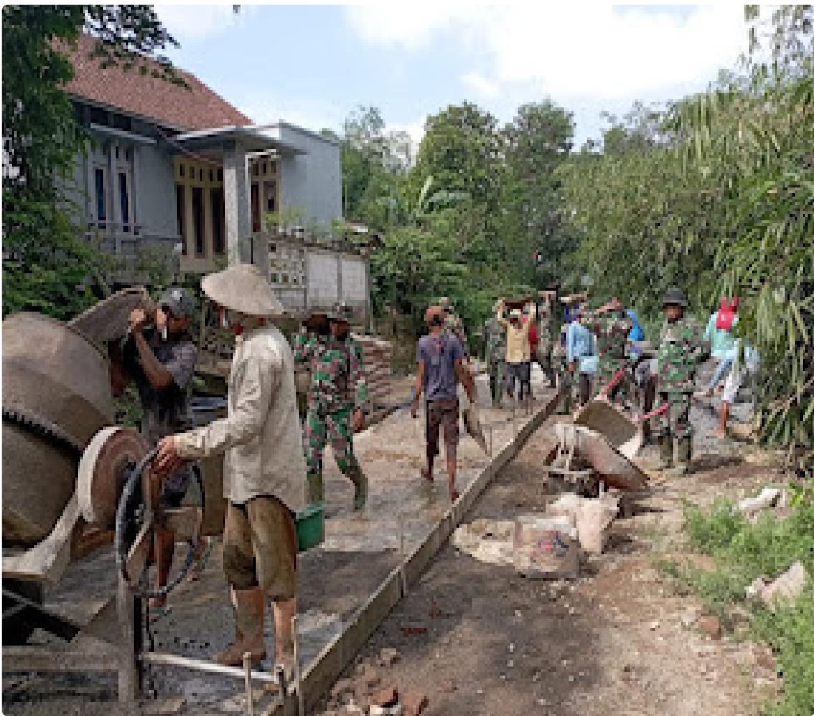
Untuk pembangunan jembatan dengan ukuran panjang 12 meter, lebar 2,5 meter, dan tinggi 5 meter, progresnya telah mencapai 90 persen. Sementara itu, betonisasi jalan sepanjang 200 meter dengan lebar 2,5 meter dan tebal 15 cm juga sudah mencapai 80 persen.
